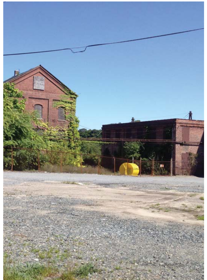
Os edifícios, que estão em estado de abandono, não são utilizados, na sua maioria, desde os anos 60.
